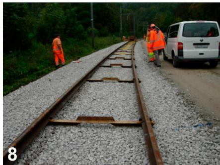
8 Einbau des neuen Gleises
