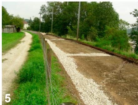
5 Einbau Drainagekiesbett zur Entwässerung des Oberbaus
