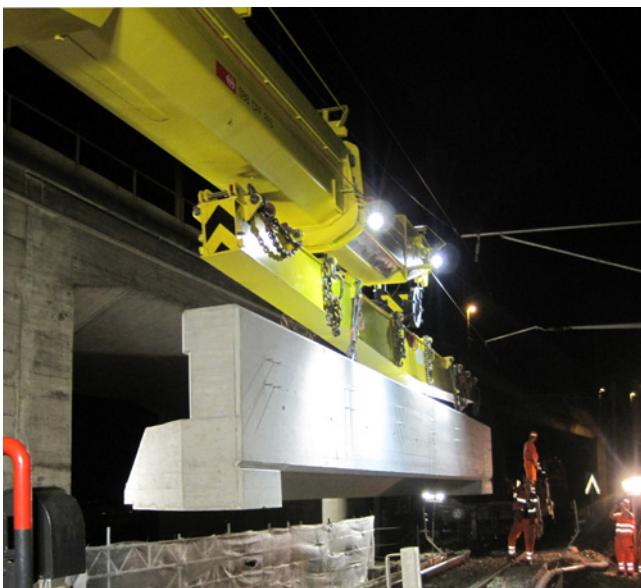
Versetzen eines vorfabrizierten Betonträgers
