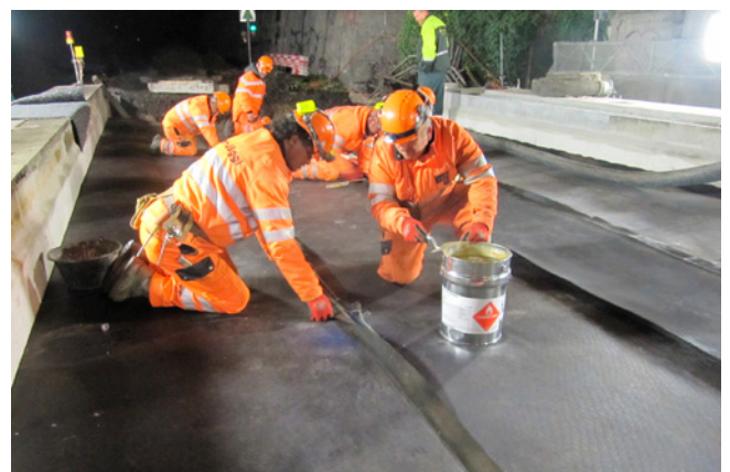
Instandsetzung Brückenabdichtung
