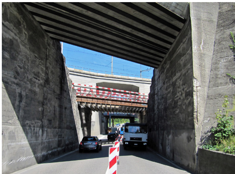
Untersicht Baueinheit 33 (Vordergrund) und 32 (mit Abschränkung)
