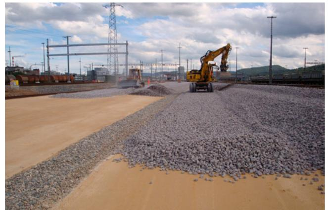
Einbau Verschotterung (gelb: mineralische Sperrschicht mit mittigem Sickergraben)
