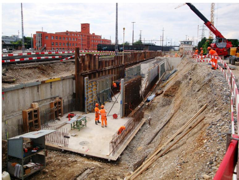
Bau UG des Normgebäudes Bahn Technik im Schutz der Spundwand
