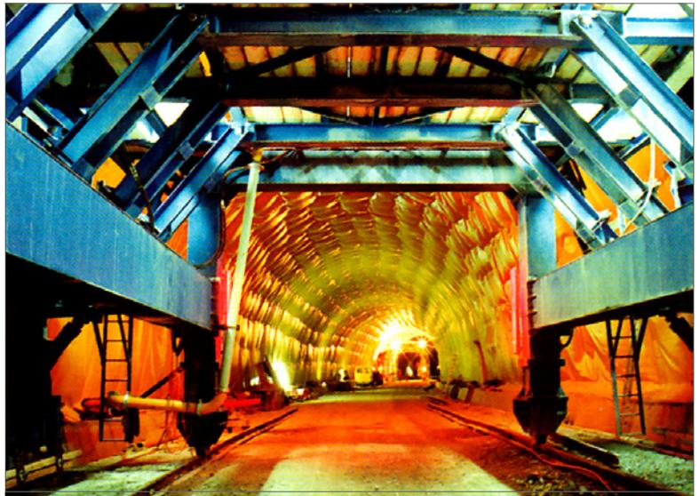
Tunnelabdichtung vor dem Betonieren des Innengewölbes
