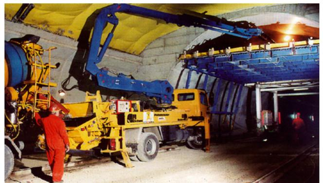
Betonieren der Zwischendecke (Sicht aus der Ausstellbucht)
