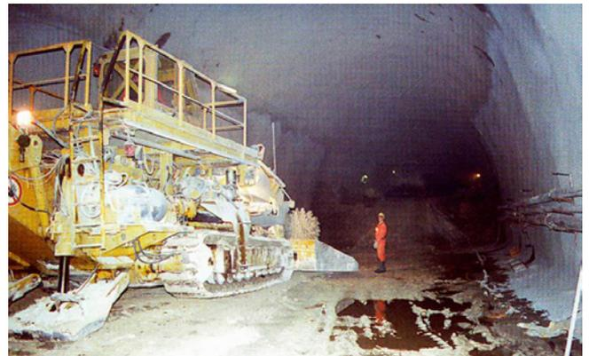
Ausbruch der Kalotte und der Strosse mit der TSM Typ ET 450 Q
